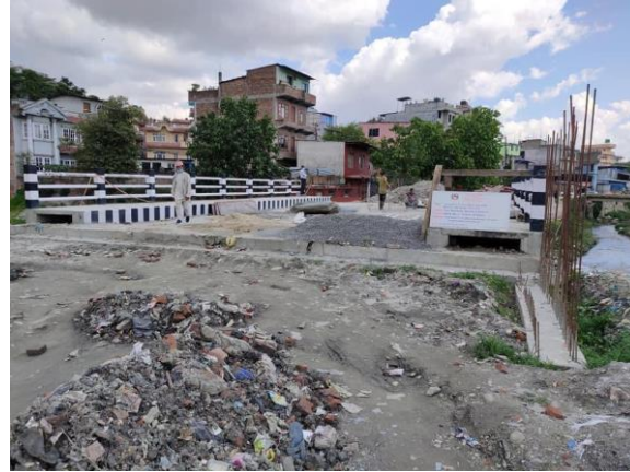
आयोजना निर्माण चरणको अवस्था
