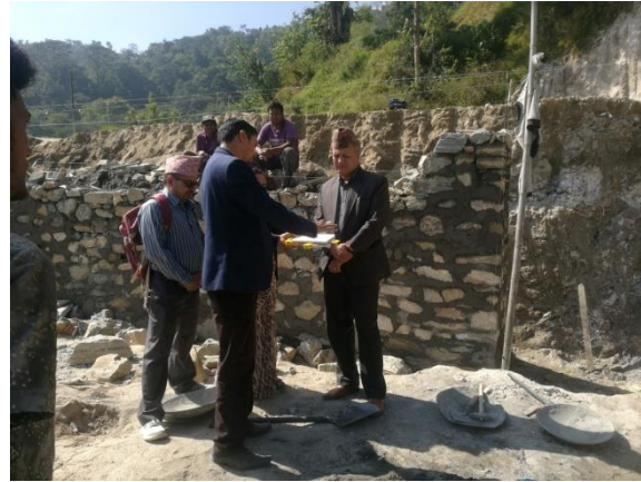
आयोजना निर्माण चरणको अवस्था
