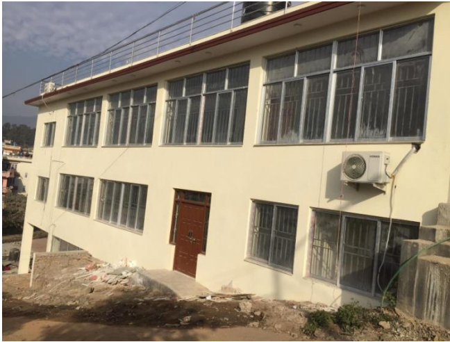
वडा नं. ११ को प्रशासनिक भवन निर्माण
