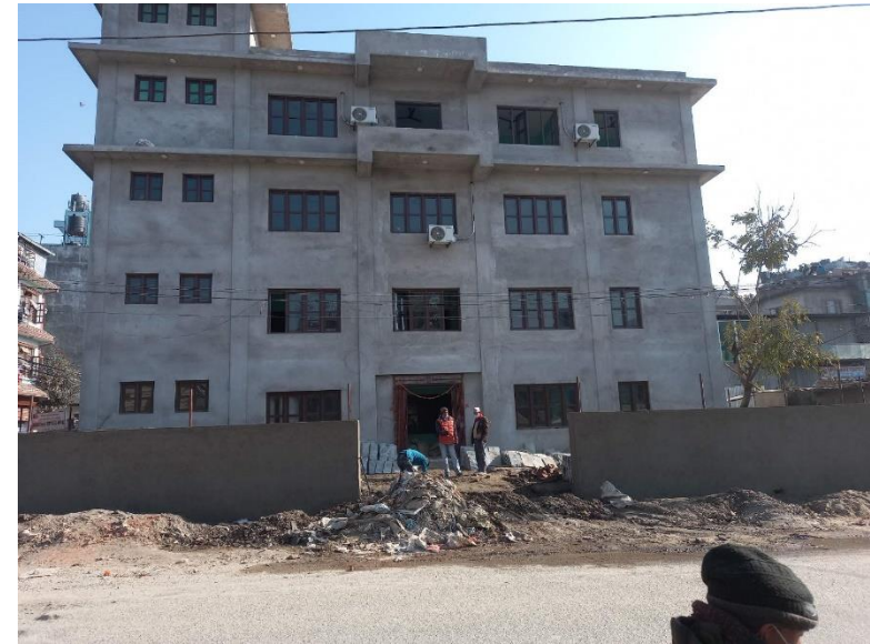
वडा नं. ९ को प्रशासनिक भवन अन्तिम तयारीको क्रममा
