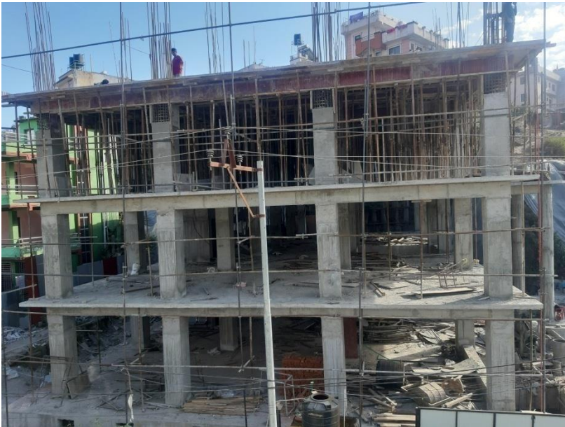
नगरपालिकाको प्रशासनिक भवन निर्माणको चरणमा
